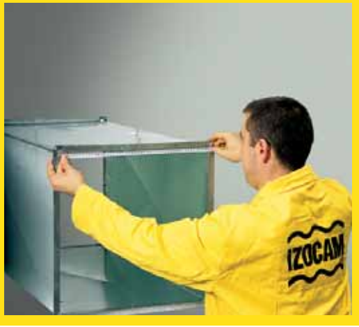
Yalıtım yapılacak kanalın içten içe ölçüsü alınır.
