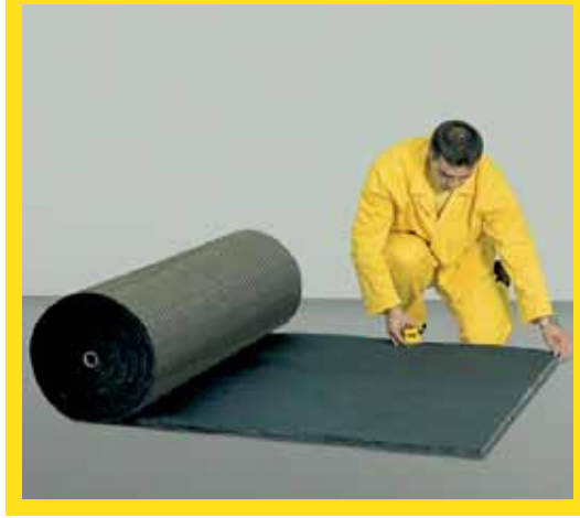
İzocam Akustik üzerinde alınan ölçü işaretlenir.
