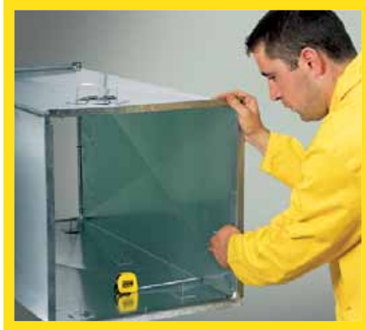
Kanal içerisine hava hızına göre kendinden yapışkanlı tespit pimleri yapıştırılır. Uygulamada pimlerin uzunluğuna dikkat edilmelidir.
