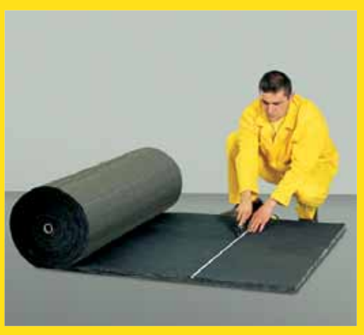
İşaretli yerden İzocam Akustik kesilir.
