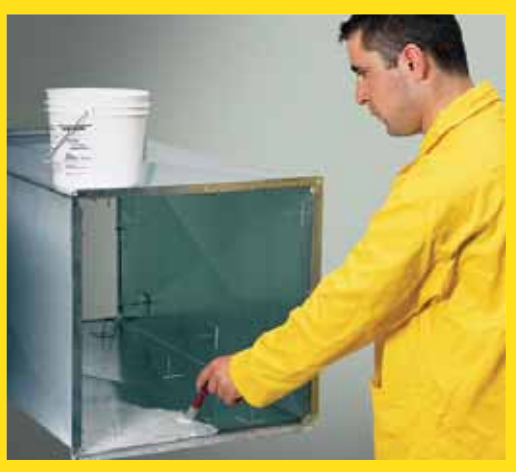
Kanal yüzeyine İzocam Akustik Yapıştırıcısı bir fırça yardımıyla sürülür.
