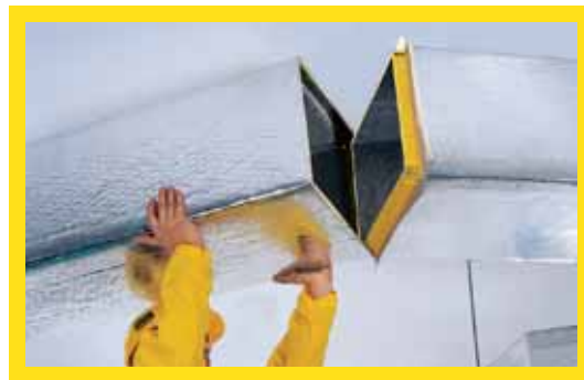
Prefabrik Klima Kanallarının birbirine eklenmesi
