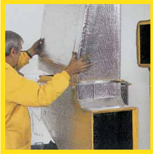
Prefabrik Klima Kanallarının birbirine eklenmesi
