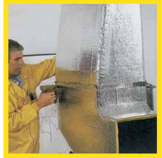
Prefabrik Klima Kanalları birleştirme yerlerinin zımbalanması
