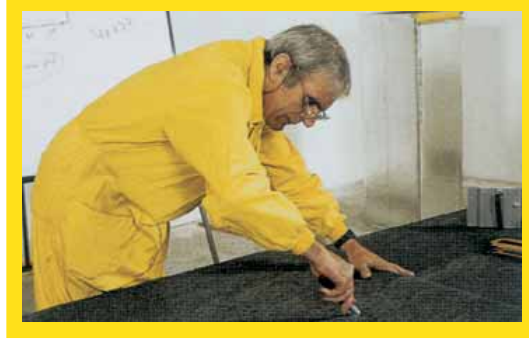
Prefabrik Klima Kanalı Levhalarının işaretlenip kesilmesi
