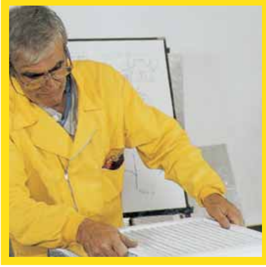
Prefabrik Klima Kanallarına menfezlerin takılması
