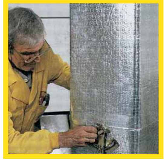
Prefabrik Klima Kanallarının hava damper montajının yapılması
