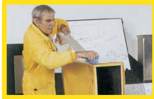
Zımbalama işleminden sonra tüm köşelerin alüminyum folyo bant ile bantlanması
