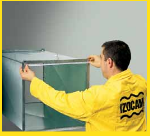
Yalıtım yapılacak kanalın içten içe ölçüsü alınır.
