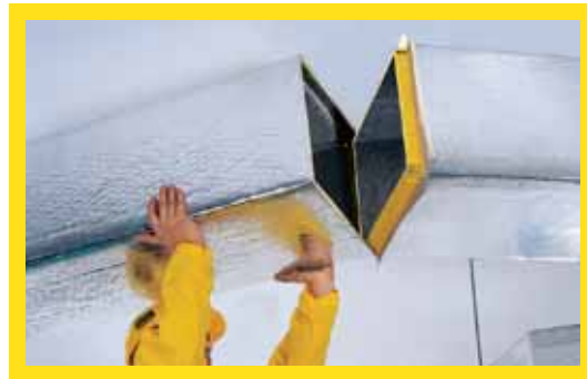
Prefabrik Klima Kanallarının birbirine eklenmesi
