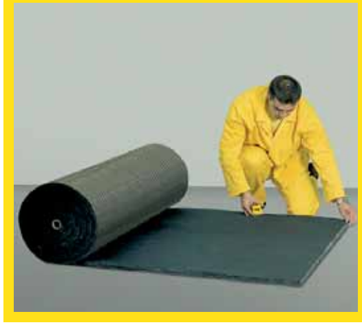
İzocam Akustik üzerinde alınan ölçü işaretlenir.
